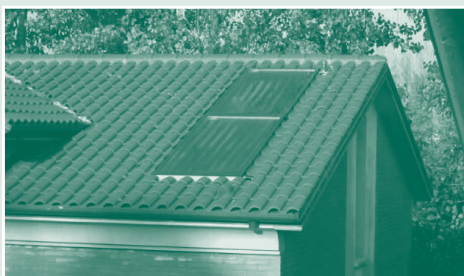
Pannelli solari termici in casa residenziale.
